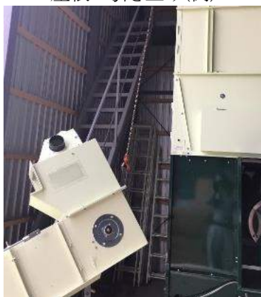
昇降機引き上げ(例 1)
