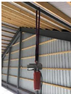
電動ウインチ取付(例)
