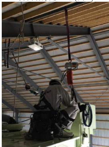
昇降機引き上げ(例 2)
